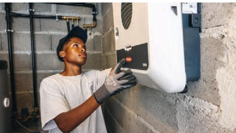
>**Installare inverter e quadri elettrici** L'inverter consente di convertire la corrente continua generata dai pannelli solari in corrente alternata, utilizzabile dalla rete elettrica.
