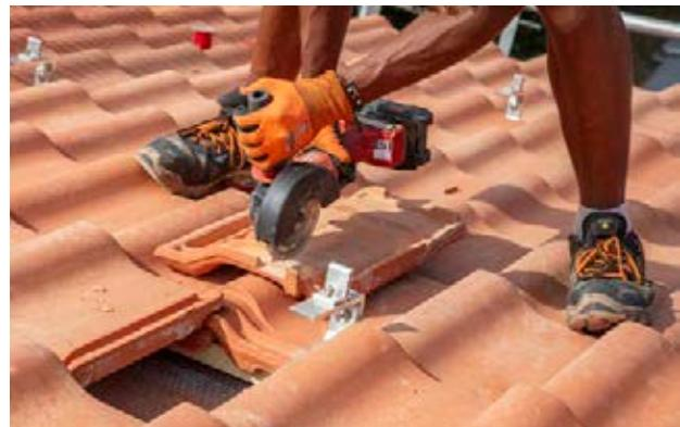
>**Adattare le tegole** Per installare correttamente ganci, binari e pannelli solari le tegole devono essere rimosse e talvolta tagliate o sagomate manualmente.
