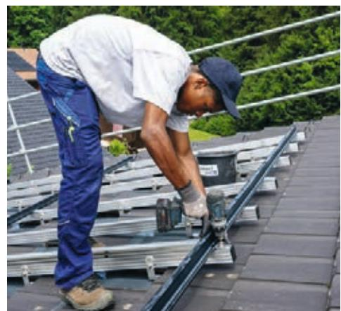
>**Installare i supporti e i pannelli solari** I ganci vengono fissati al tetto con chiavi o trapani avvitatori. Questi elementi costituiscono la base su cui sono montati i binari destinati a sostenere i pannelli.
